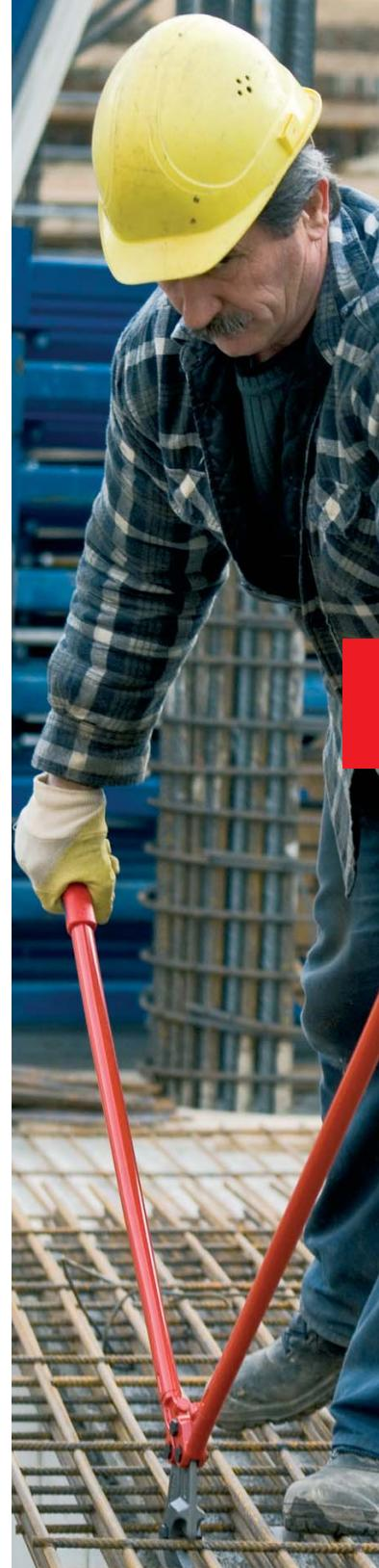
Zvláštní tvar hlavy pákových kleští na pletivo 71 82 950 umožňuje řezání ploché konstrukční oceli
